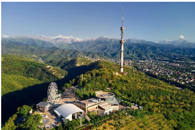
"Cidade da Maçã" em frente à Colina Kok Tobe e às Montanhas Tian Shan
